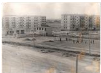
Начало строительства школы
